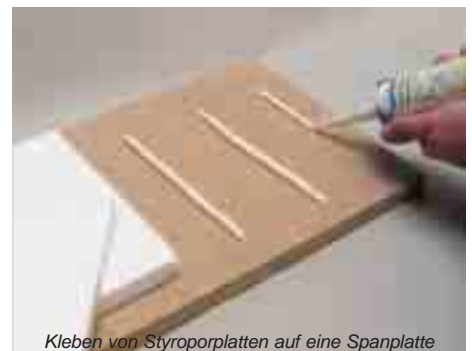
Kleben von Styroporplatten auf eine Spanplatte Bonding of polystyrene plates to a flake board
