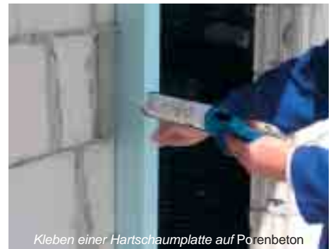
Kleben einer Hartschaumplatte auf Porenbeton Bonding of a form piece made of rigid expanded plastics to a foam mortar
