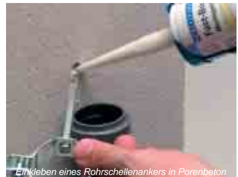
Einkleben eines Rohrschellenankers in Porenbeton Fixing of a wall clamp to foam mortar
